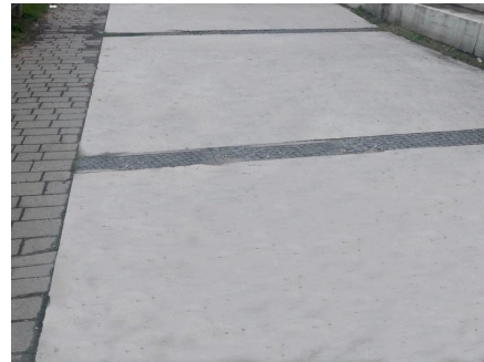
Nach Sanierung barrierefrei
