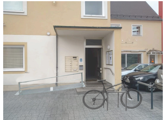
Eingangssituation mit Metallrampe
